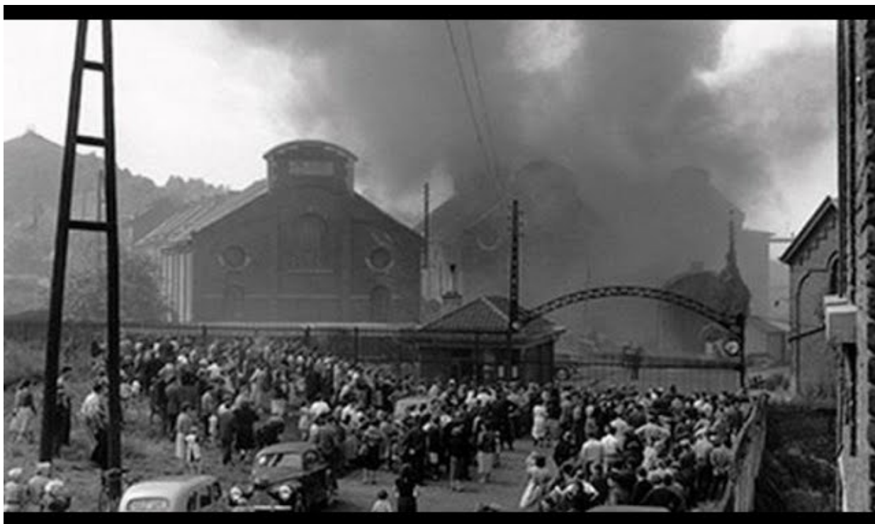
L'ingresso della miniera e il fumo dell'incendio ormai fuori controllo
