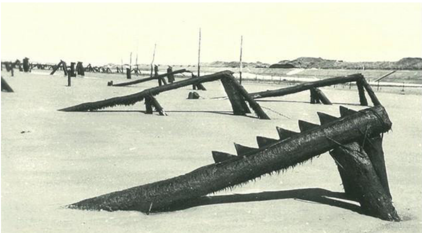
OSTACOLI ANTISBARCO MUNITI DI LAME METALLICHE
