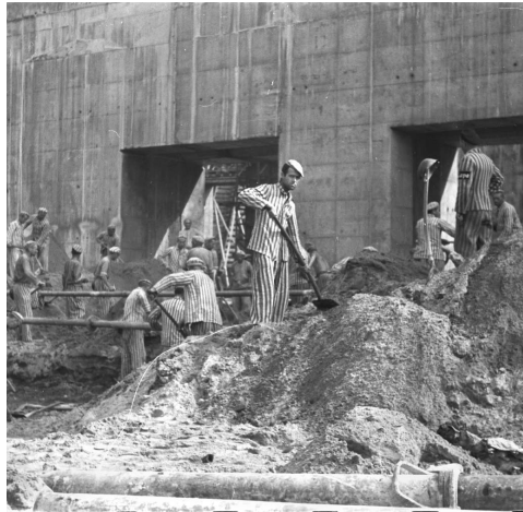
OPERAI DELL'ORGANIZZAZIONE TODT AL LAVORO NELLA COSTRUZIONE DI UN BUNKER
